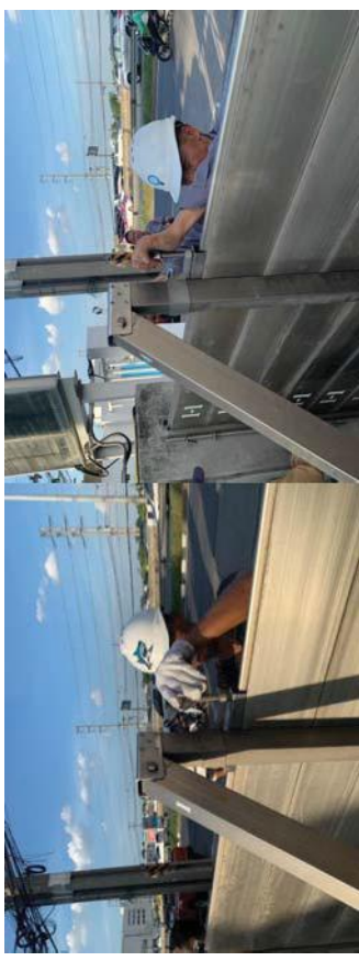
ทำการขันยึดสื่อด้านบานประตู( กดลงเพื่อให้บานประตูติดพันกันให้แน่น )
