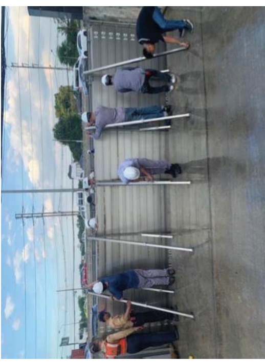
ทำการประกอบเอาตัวเข้าในแนวตั้งด้านเพื่อป้องกัน และเพื่อความแข็งแรงของประตู
