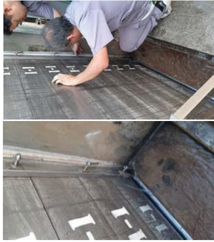
จากการตรวจสอบพบว่ายังไม่ได้ขันสกรูจึงทำให้ น้ำไหลเข้ามาได้
